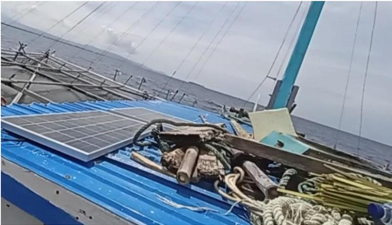
**Gambar 5.4.** Area penempatan Panel surya di atap bagan nelayan
